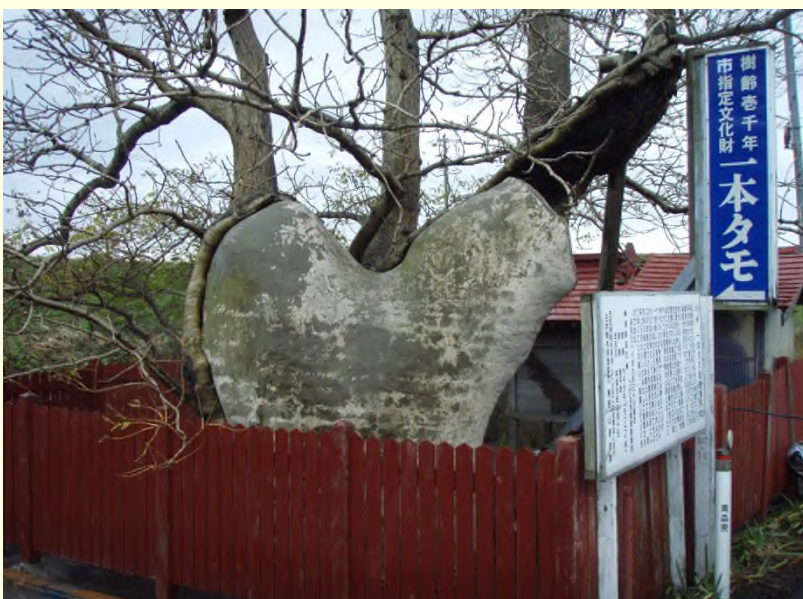
一本タモは、腐朽が激しく、開口部分をコンクリートで整形している。
