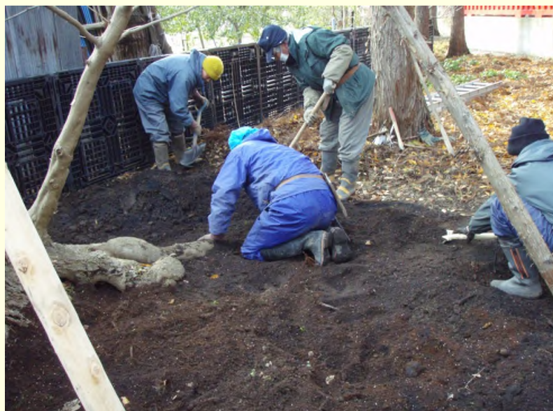
土壤改良工実施中
