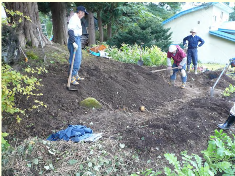
土壌改良工実施中
