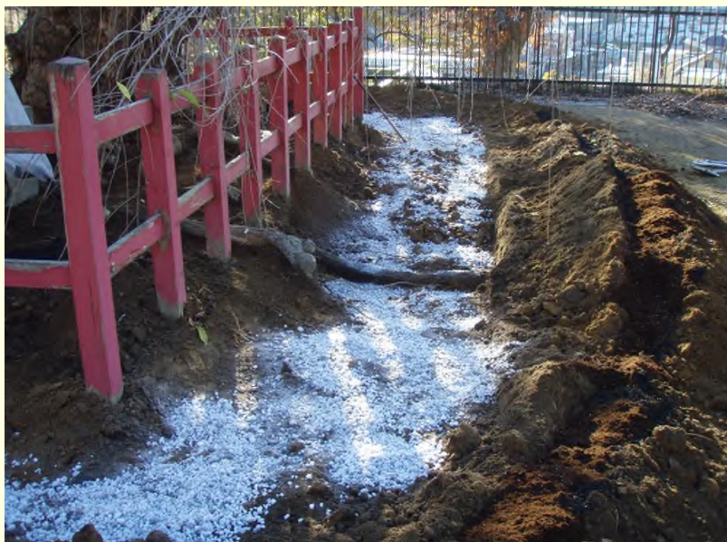
土壌改良工実施中
