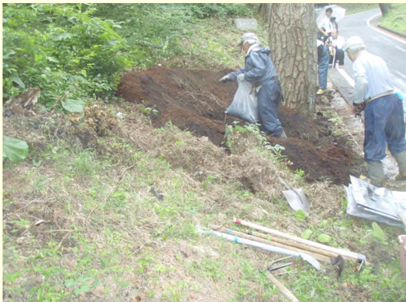
土壌改良工実施中
