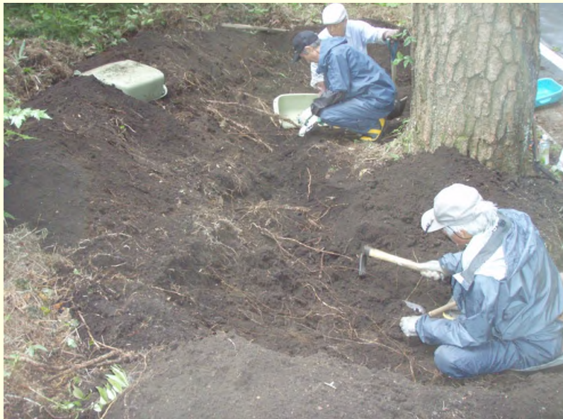
土壌改良工実施中
