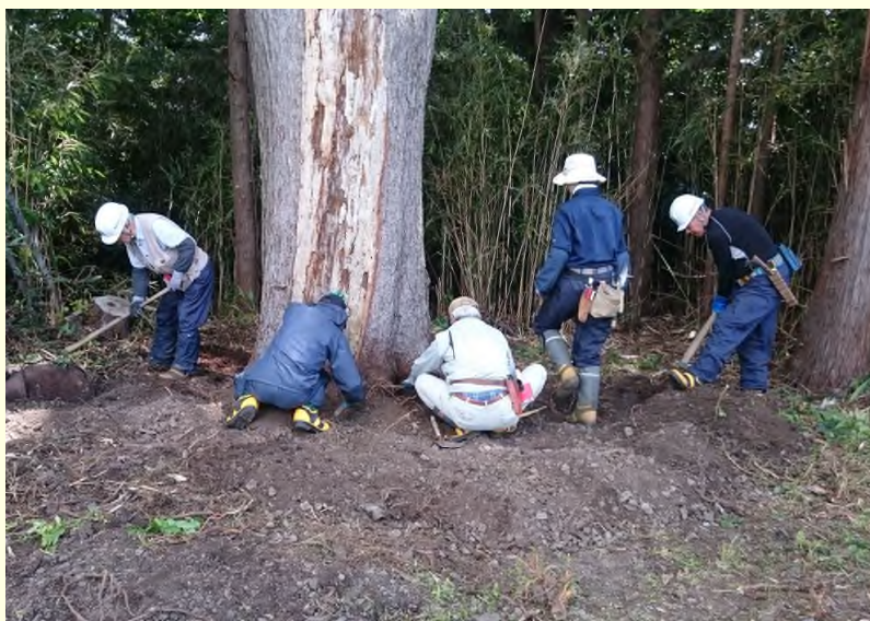
土壌改良のため表土の掻き取り
