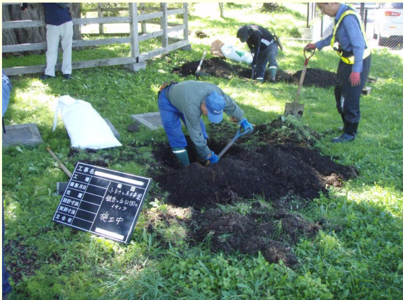
土壤改良工 表土のつぼ掘作業 円周70cm*深さ50cm
